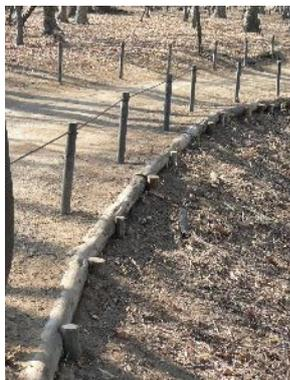
路肩の一部では、雨による浸食も起きているため、間伐材を使って補修しました。
