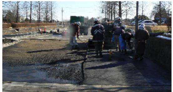
かつて御所沼だったこの場所は、かねてから地盤沈下が課題。今回、雨水がスムーズに流れるように側溝と園路の高さを上げて、部分補修しました。
