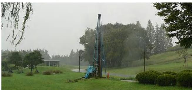
これまで、中山の流れは、御所沼の水を循環させていました。深さ100m程の地下水をポンプでくみあげて、中山の流れを経由して、御所沼へ注ぎ込むようにします。きれいな水で、せせらぎ遊びも、一段と熱気を帯びそうです。施工業者によると、水がくみ上げられるようになるのに、2~3週間かかるとのこと。この工事の進捗状況を見るのも、また、ひとつの楽しみとなりそうです。
