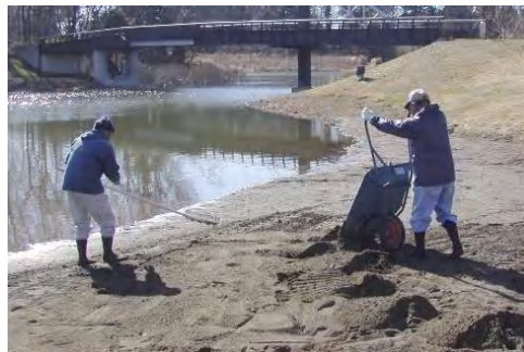
草の生えた表土10cm程を除去し、新しく砂を敷き直し。
